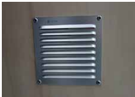
Grille d'aération inter
