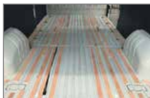
Lattage de compensation des ondes
