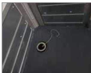
Plancher résiné antidérapant avec siphons d'évacuation
